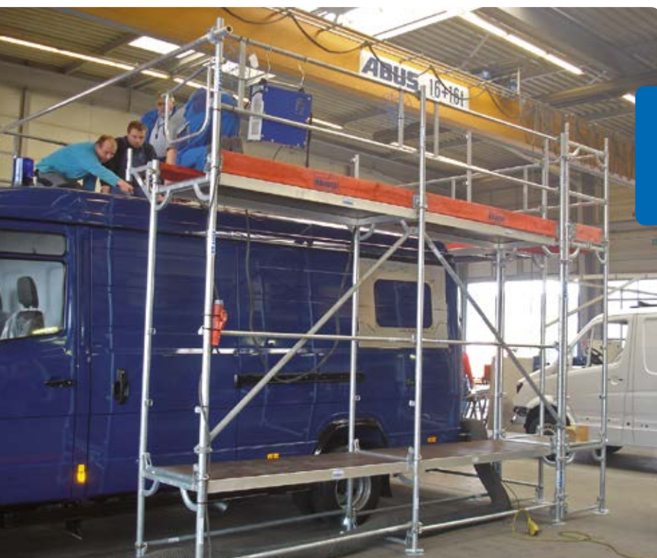
Konstrukcja z rusztowań stacjonarna z platformą w kształcie litery U
