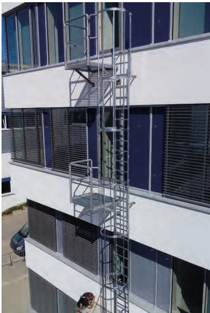
Drabina pionowa, jednociągowa
