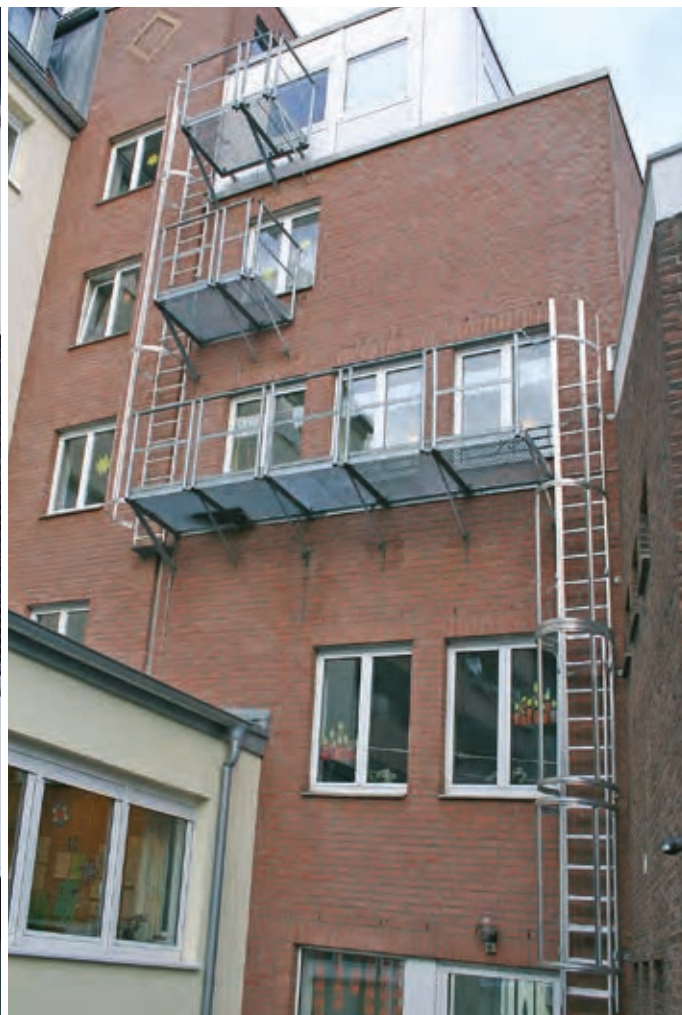
Drabina pionowa, wielociągowa
